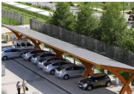
Photo : Parking solaire pour véhicules électriques (© P.Avavian/CEA)
