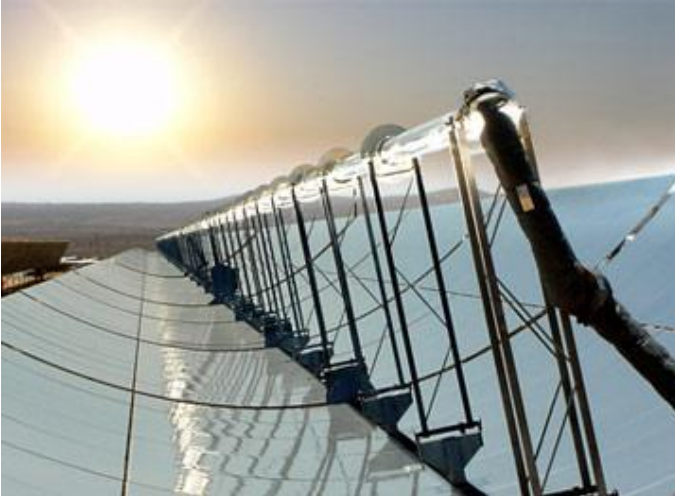
Photo : Centrale solaire à collecteurs cylindro-paraboliques (© Schott Solar)
