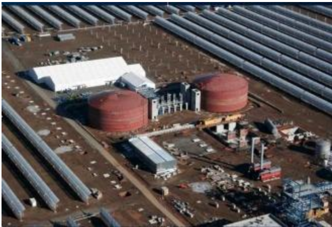
Photo : Cuves de stockage thermique (© Solar Millennium AG)
