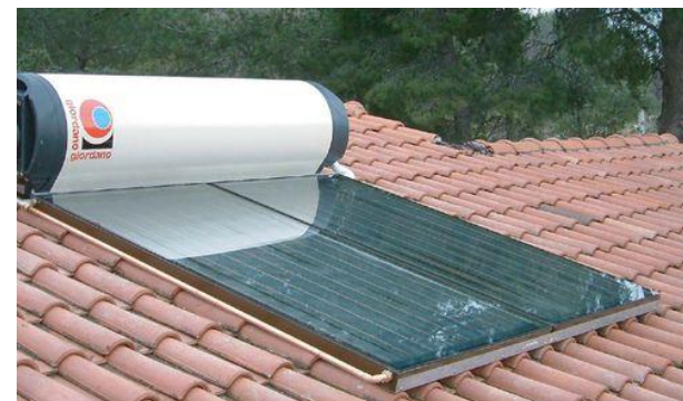
Photo : chauffe-eau solaire monobloc (© Giordano/Solaire Azur)
